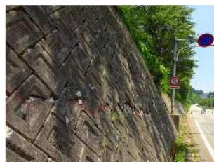
写真-2 ブロック積亀裂状況
