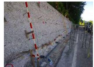
写真-5 擁壁補強施工状況
