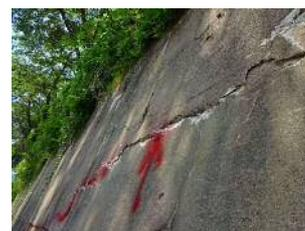
写真-3 擁壁亀裂状況
