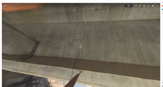
写真-9 360度カメラ画像ビューワによる変状調査
